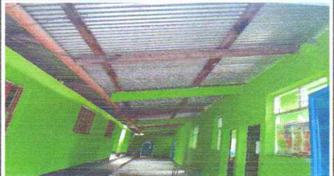
Foto 4: Sustitucion del Sistema Electrico
