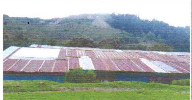
Foto 2: Cambio de Techo por Lamina Troqueola Aluzinc Calibre 26
